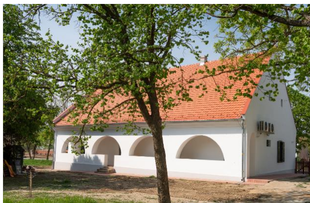
2 A felújított boltíves tornác Kiss Géza egykori udvarából
